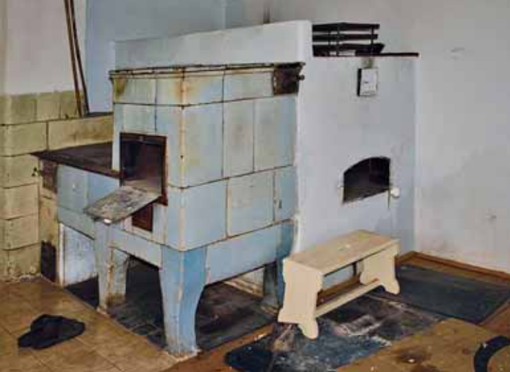
Čestice čp. 65 – dochovaný sporák s pecí, chléb se vkládá ze světnice. Čestice Nr. 65 – erhaltener Sparherd mit Backofen, das Brot wird von der Stube aus eingebracht.
