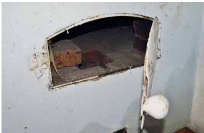
Čestice čp. 65 – dochovaný sporák s pecí, chléb se vkládá ze světnice. Čestice Nr. 65 – erhaltener Sparherd mit Backofen, das Brot wird von der Stube aus eingebracht.
